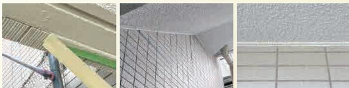
【注意】 養生材を除去する際、塗布厚のつき過ぎにより、上塗り塗膜ごと引っ張られる場合は塗装箇所と非塗装箇所の境目にカッターを入れ、切りながら養生材を剥がしてください。
