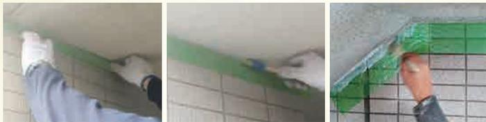
①養生材を貼り付ける。 ②刷毛の毛先を利用して養生材に含ませる。 ③浮き部分にアクリコ®NBをかぶせる。
