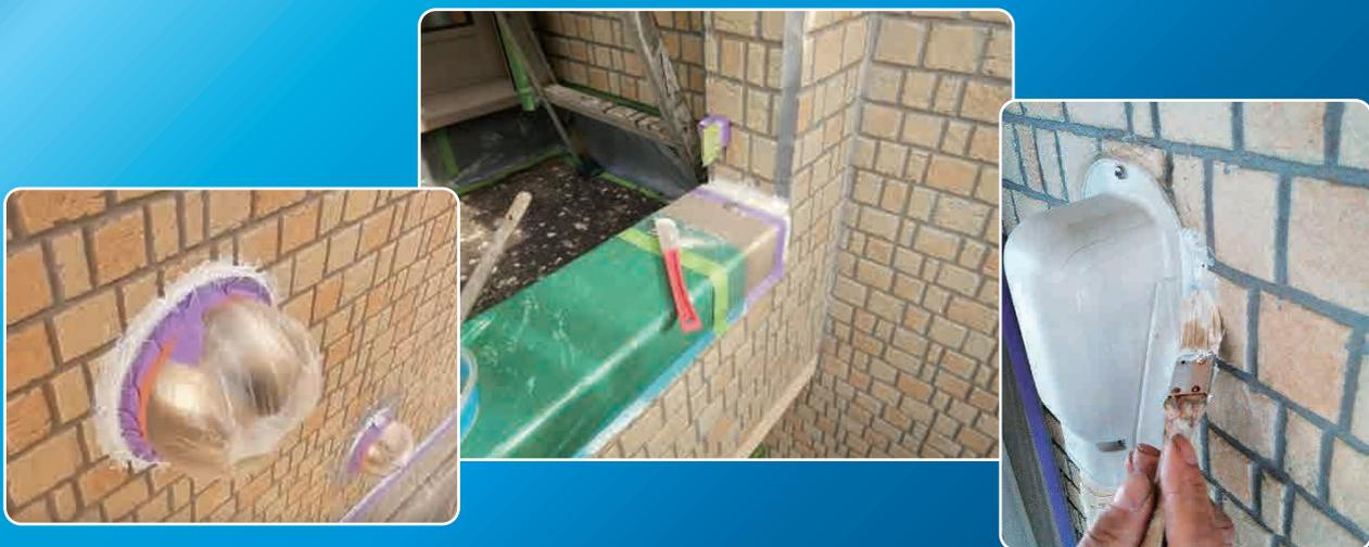
先打ちシリコン系シーリング材に打設すれば **塗装仕上げができる!**
