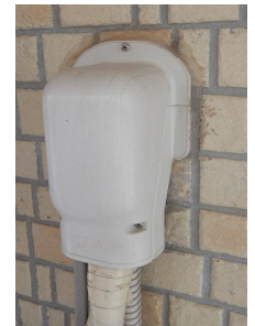
エアコンホースカバー周り
