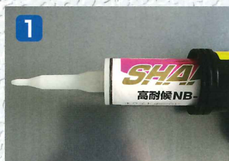
1 シーリング材にインナーノズルをセット
